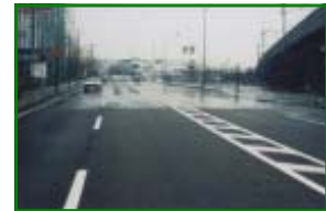
道路用アスファルト改質 手前：排水性舗装に使用 奥：一般舗装
